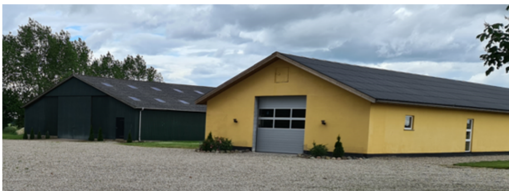
Eksisterende driftsbygning beklædt med gule stålplader på facaderne og sorte stålplader på taget
