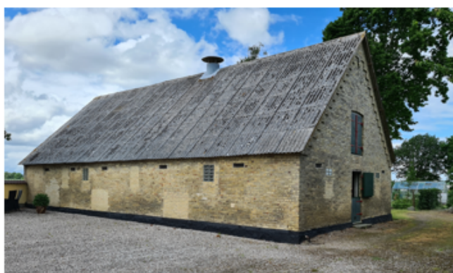
Svinestalden, der ønskes nedrevet
