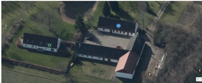
Øverst set fra nord. Nederst set fra syd. Grøn cirkel indikerer nuværende stuehus, blå cirkel indikerer forhenværende stuehus, nu sommerhus, det er denne bygning der ønskes nedrevet.
