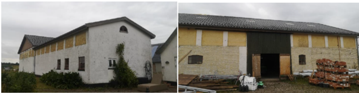
Venstre: Bygning 2 der ønskes nedrevet set fra øst. Højre: Bygning 3 der ønskes delvist nedrevet, set fra vest.
