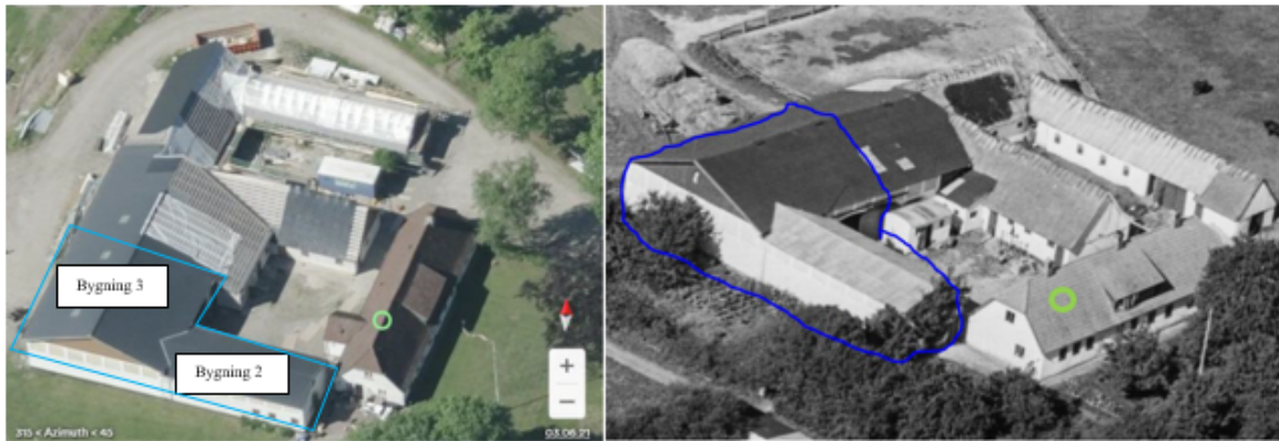
Venstre: Oversigt over ejendommen skråfoto fra 2022, set fra sydvest. Bygningerne der ønskes nedrevet er markeret med blå, halvdelen af bygning 3 forbliver. Grøn cirkel: stuehus. Øvrige udhusbygninger ses nordfor. Det ses, at der er en gennemgående renovering i gang af udhusbygningerne Stuehuset ses at være velbevaret. Højre: Oversigt over ejendommen indsendt af Bygningskultur Ringsted, billedet er fra 1939, set fra sydvest. Bygningerne der ønskes nedrevet er markeret med blå, halvdelen af bygning 3 forbliver. Grøn cirkel: stuehus. Øvrige udhusbygninger ses nordfor.
