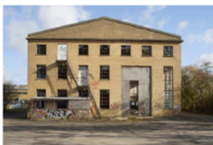
Tilbygningen til bygningsnr. 1, der er opført med fladt tag, slører den oprindelige bygning gavlfacade.
