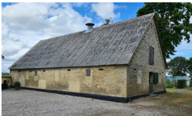
Svinestalden, der ønskes nedrevet
