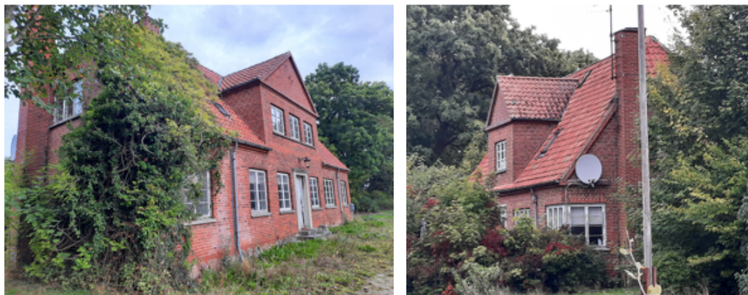
Det bevaringsværdige stuehus på Hovmarken 20, facader mod øst og vest.
